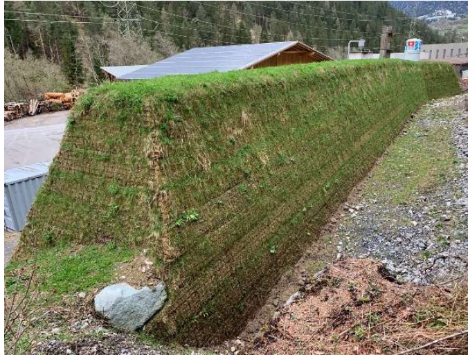
Schutzdamm, (bewehrte Erde)
