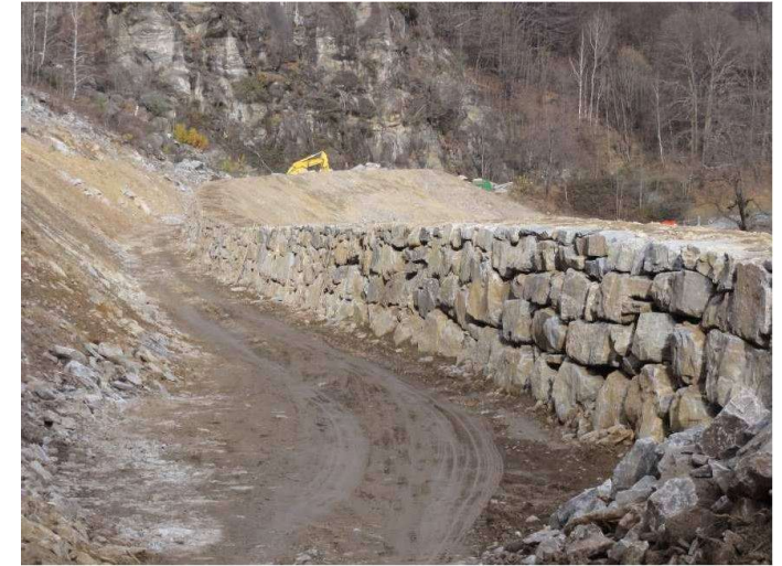
Schutzdamm, (mit Blocksteinen verkleidet)
